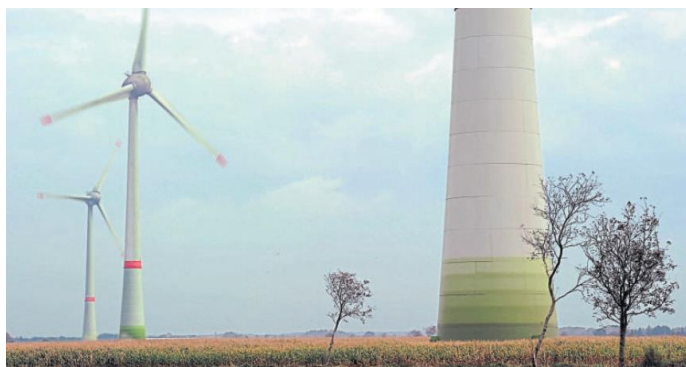
Drei Windanlagen sollen in Staufenberg errichtet werden.
