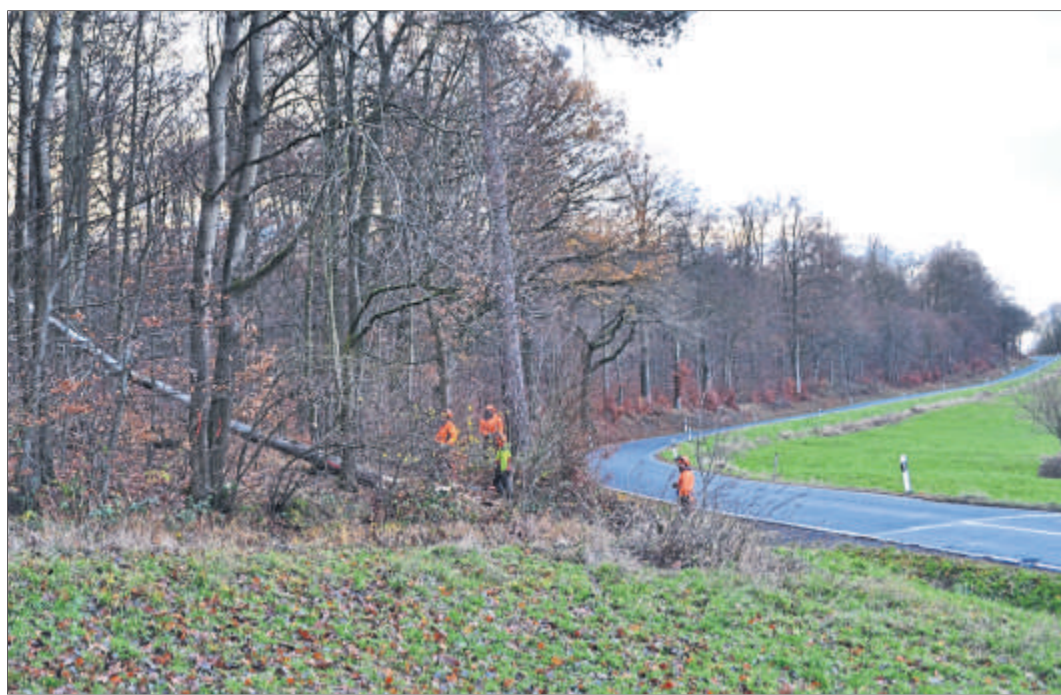
»Baum fällt!«, rufen sich noch bis Freitag »Orange-Westen« an der Landstraße zwischen Lauter und Laubach zu. Auftraggeber der Arbeiten ist das Land, als Eigner des Waldstückes steht es in der Verkehrssicherungspflicht. (Foto: tb)
